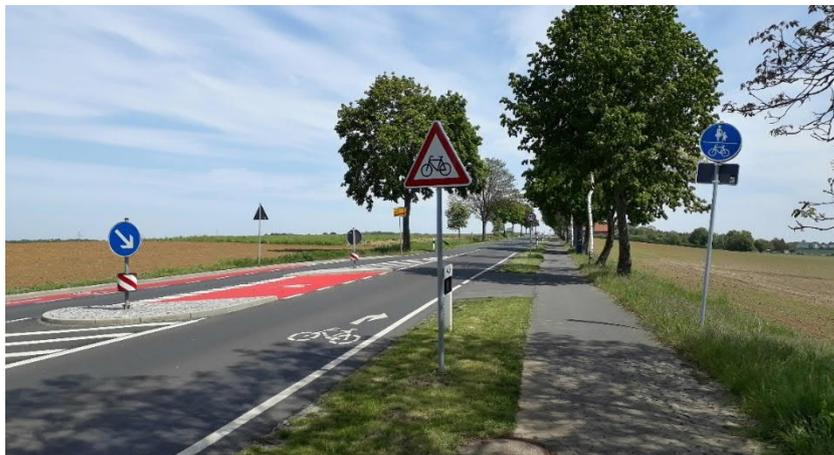
Abb. 33 Markierung von Fahrradpiktogrammen auf der Fahrbahn Übergang Fahrbahnführung innerorts und außerorts benutzungspflichtige Radverkehrsanlage (Seelze)
