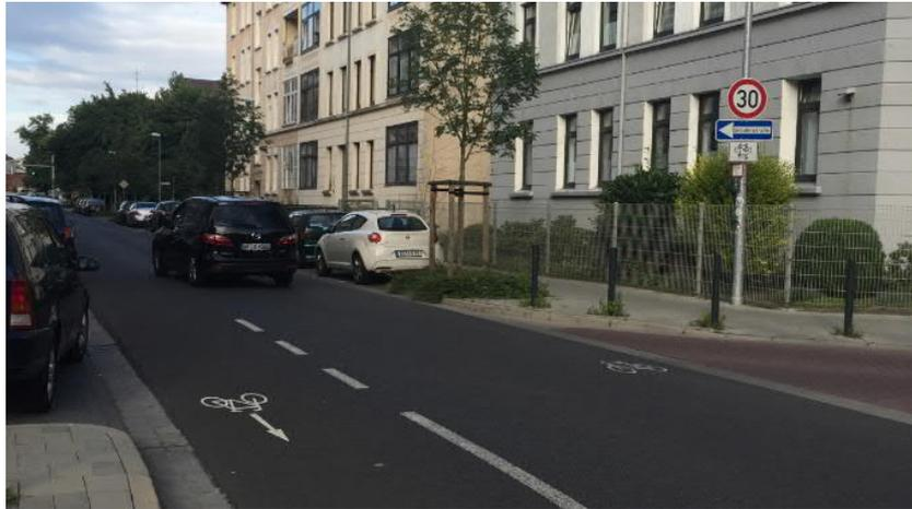
Abb. 32 Markierung von Fahrradpiktogrammen auf der Fahrbahn (Braunschweig)
